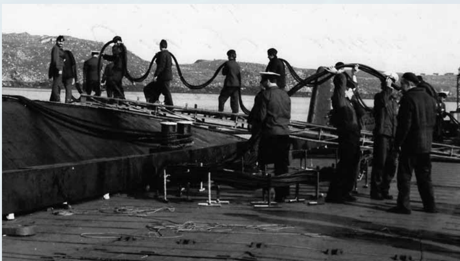
Подключение концов электропитания с берега
